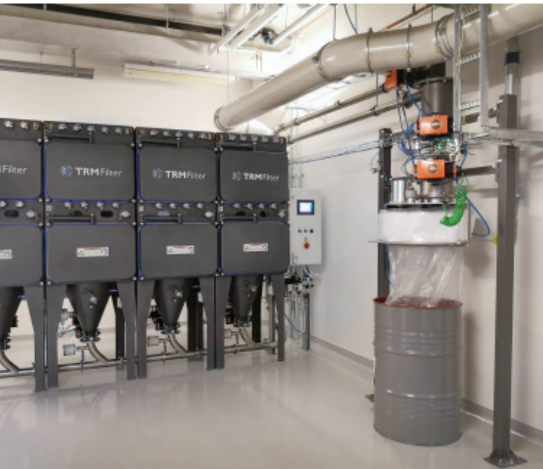
TRM-Filter-Entstaubungsanlage der ECR-Baureihe mit zentraler Staubsammlung und einem Endlosliner (Pharma-Anwendung).
